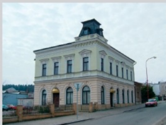
Administrativní budova - kotelna je umístěna v přízemí budovy, v obdobných objektech však byly realizovány i kotelny v podkroví
