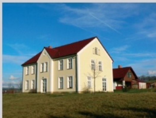
Rodinný dům, selské stavení - kotelna je umístěna v samostatné hospodářské budově včetně dalšího zázemí (přístřešek pro auto, dílny, sklep ...)
