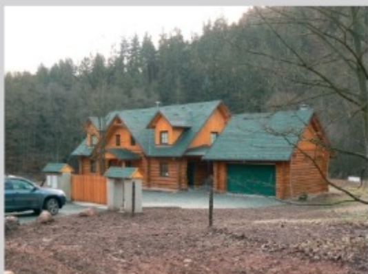
Dřevěný srubový dům - kotelna (včetně skladování paliva) je umístěna ve společném objektu s garáží
